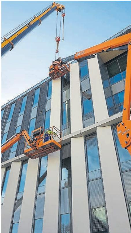
Anbau der Fassadenelemente aus Beton
