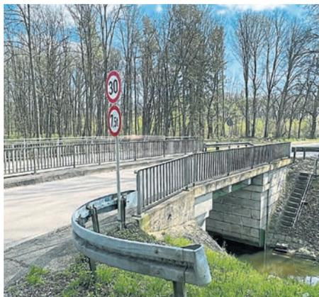
Die bestehende Straßenbrücke über den Ludlgraben (Mitterschüttweg) musste aus statischen Gründen auf 7,5 Tonnen beschränkt werden. Um die Erreichbarkeit des Baggersees auch für schwerere Fahrzeuge wieder zu ermöglichen, wird eine Behelfsbrücke gebaut. Im zweiten Halbjahr wird die aktuelle Brücke abgerissen und für knapp eine halbe Million Euro eine neue Brücke gebaut. Während der Baumaßnahme ist mit Verkehrsbehinderungen zu rechnen.
