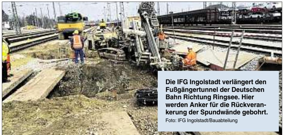
**Die IFG Ingolstadt verlängert den Fußgängertunnel der Deutschen Bahn Richtung Ringsee. Hier werden Anker für die Rückverankerung der Spundwände gebohrt.**
